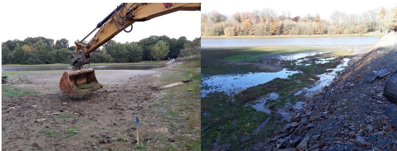
Sept. 2018 : Chantier de transfert des pieds de Littorelles et du Limon – Oct. 2019 : recolonisation par la végétation.
